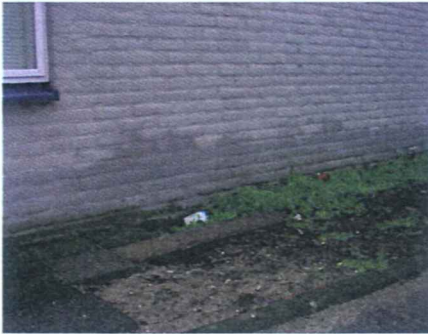
Optrekkend vocht door een te hoge grondwaterstand.
