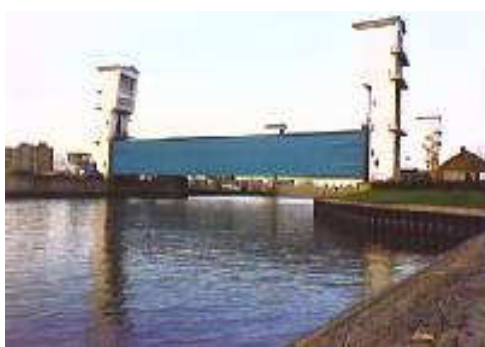
Figuur 29 Stormvloedkering Hollandse IJssel nabij Rotterdam
